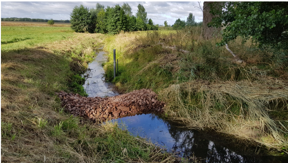
Denitrifikationsstrecke mit Wasserstandspegel in der Ehle
