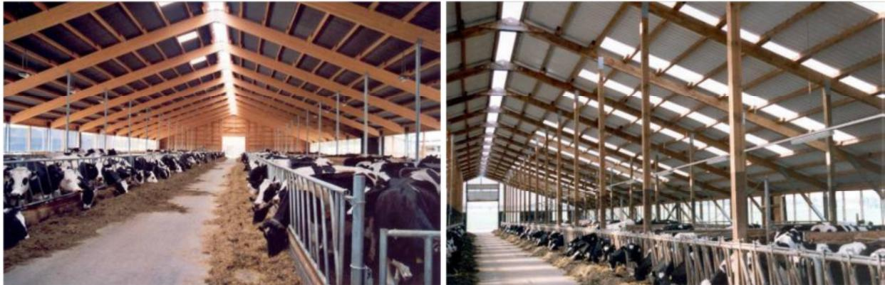
**Abbildung 19: Empfohlene Anordnung von Lichtplatten (links) und ungünstige Anordnung (rechts)**
