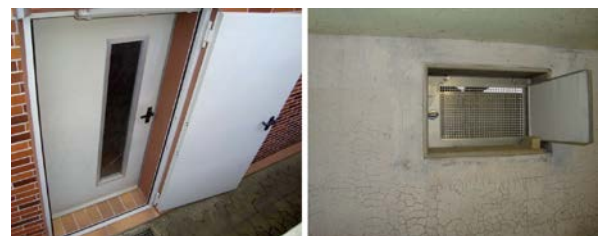
Abbildung 28: oben: hochgemauerter Kellerfenserschacht, dieser verhindert das Eindringen von Wasser und Schlamm in den Keller; unten: nachträglich angebrachte Einbauten zum Schutz vor eindringendem Wasser und Schlamm in Kellertüren und Fenstern (20).
