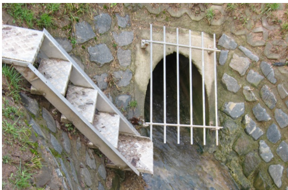
Abbildung 27: Rechen zur Freihaltung eines Einlaufs. Durch die Treppe wird eine einfache Reinigung und Kontrolle des Rechens ermöglicht.
