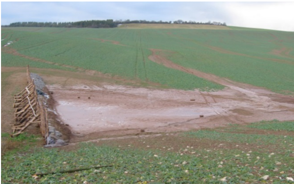
Abbildung 43: Errichtung einer provisorischen Befestigung aus Holzbalken und Sandsäcken auf einer landwirtschaftlich genutzten Flächen bei Riestedt im September 2011 zum Rückhalt von Schlamm
