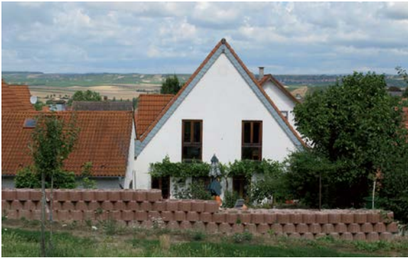
Abbildung 29: Mauer zum Schutz vor zufließendem Außengebietswasser (20)
