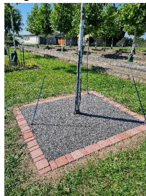
wasserdurchlässige Baumscheibe Terrasystem®
